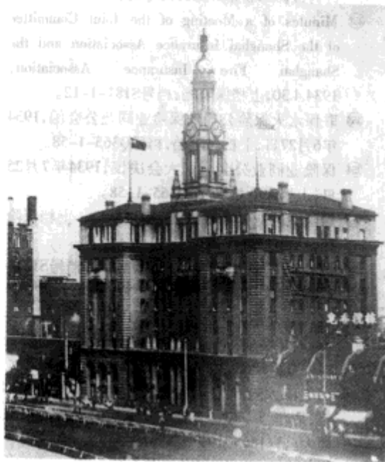
华安合群人寿保险公司曾是近代中国华资保险业的“老大”。图为建于1926年的华安合群人寿保险大楼(后改为金门饭店)
